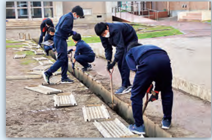
グラウンド側溝上げ
