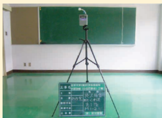
除去完了後の粉じん測定
