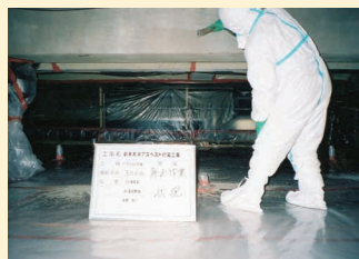
ロックウール吹付け材及び ひる石吹付け材除去作業
