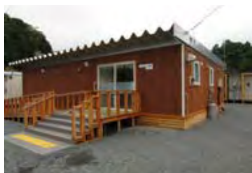
「復興ボード」を用いた仮設集会施設
