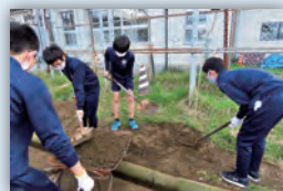
グランド側溝上げ
